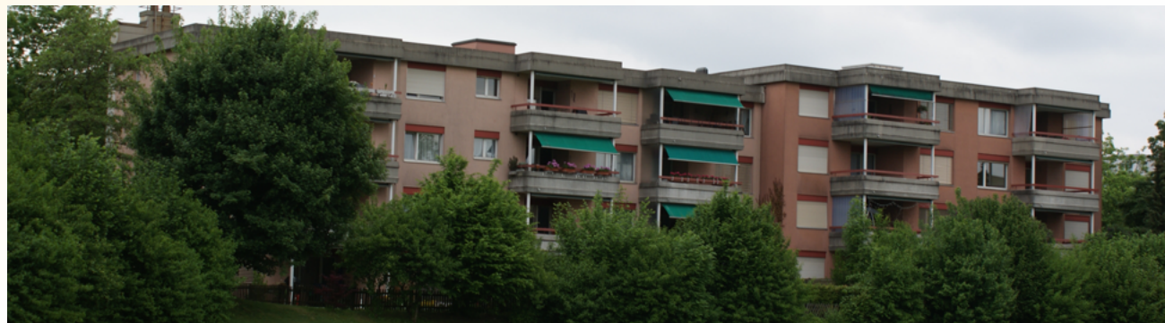
Die Liegenschaft am Mythenweg vor der Sanierung.
