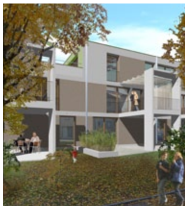
Projekt Wiesenstrasse, Winterthur Neubau
