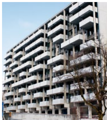
Projekt Riedmatt, Zug Sanierung
