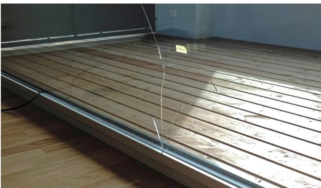
In Schiebetüranlagen mit Wärme- und Sonnenschutzgläsern kann sich zwischen den, im geöffneten Zustand hintereinander stehenden, Scheiben durch direkte Sonneneinstrahlung ein Hitzestau bilden, der ebenfalls zu einem Thermoschock führen kann. Das gleiche Problem ergibt sich oft auch bei infrarotreflektierenden Rollos oder Vorhängen mit ungenügender Luftzirkulation.
